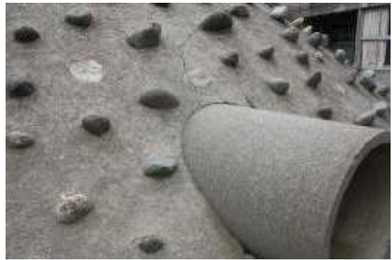
【修理後の穴をコンクリートでうめた築山】
