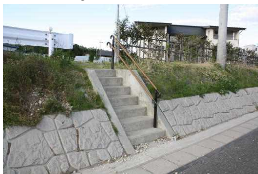
【手すりのついた階段】
