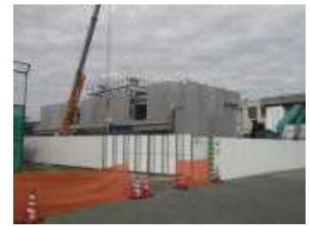
【工事中の南校舎】
